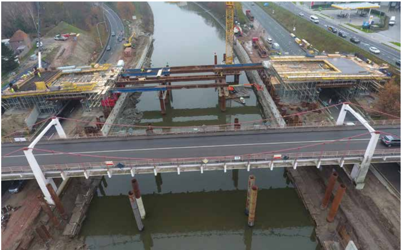
Foto van de huidige Bergwijkbrug en de nieuwe die wordt opgebouwd, genomen begin december 2020. Eind juni/begin juli 2021 wordt de nieuwe brug op zijn definitieve plaats geschoven.
